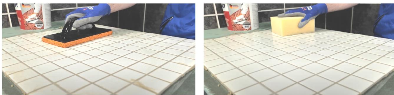
Рис. 37. Диагональными движениями шпателя убрать с поверхности плитки излишки затирки
